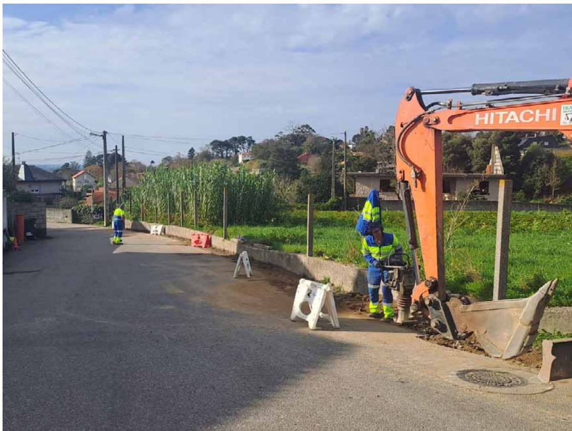
Finaliza la renovación del abastecimiento de las calles Costina y Seixas Alto en Nigran
